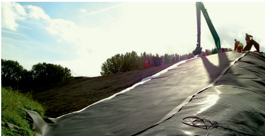
Foto: Overzicht aanleg IBC-werk.
