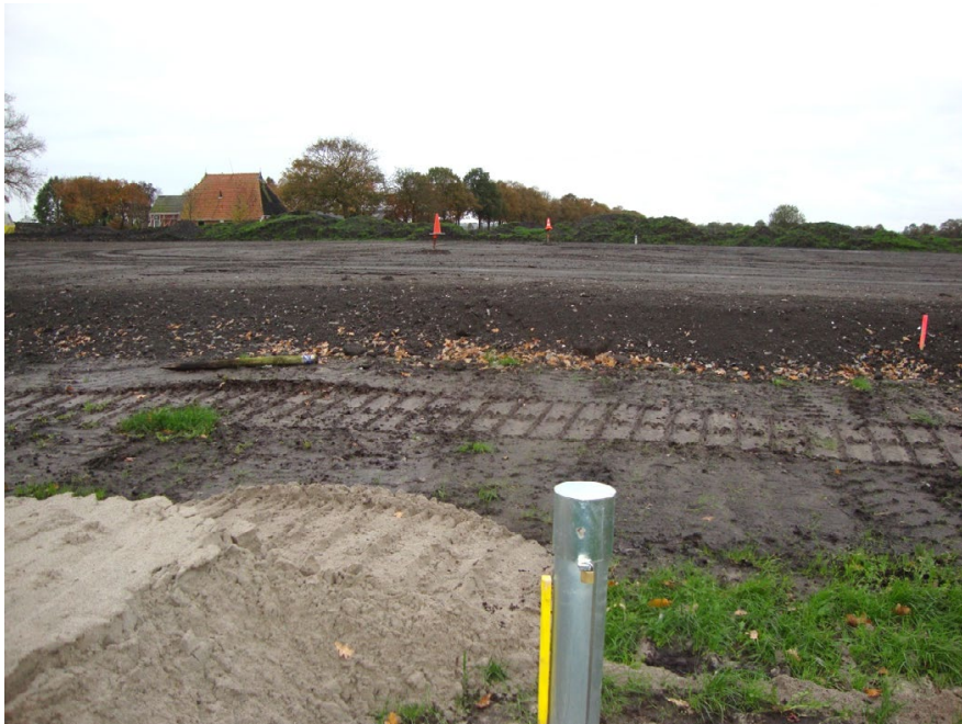
Foto: Bij 20: Monitoringsvoorziening: aanbrengen peilbuis.
