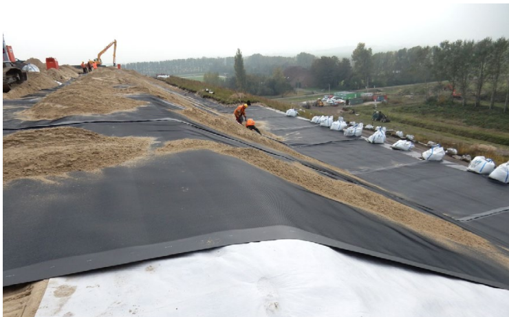
Foto: Aanbrengen geotextiel en HDPE-folie.
