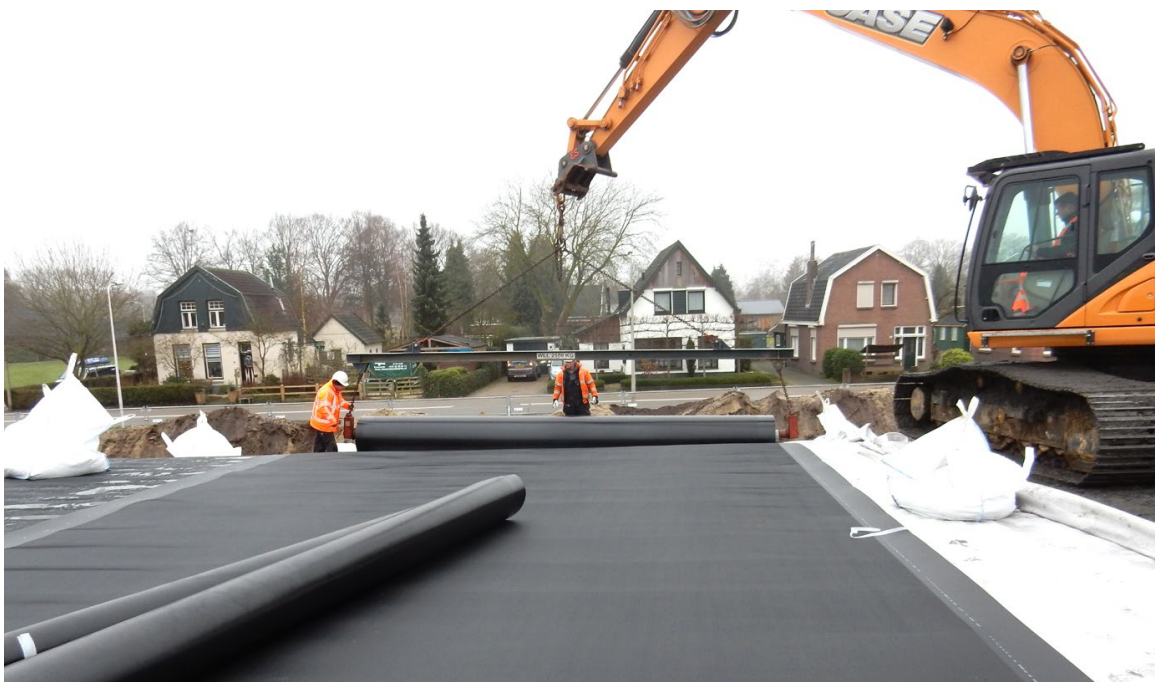
Foto: Aanbrengen HDPE-folie.
