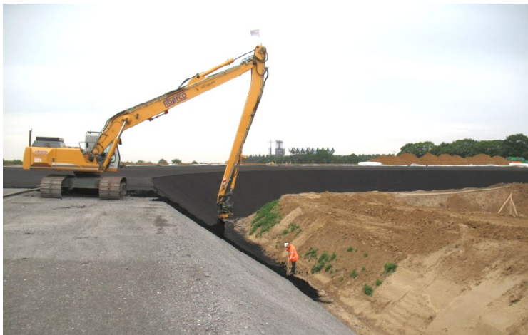
Foto: Aanleg van zandbentonietpolymeergel.
