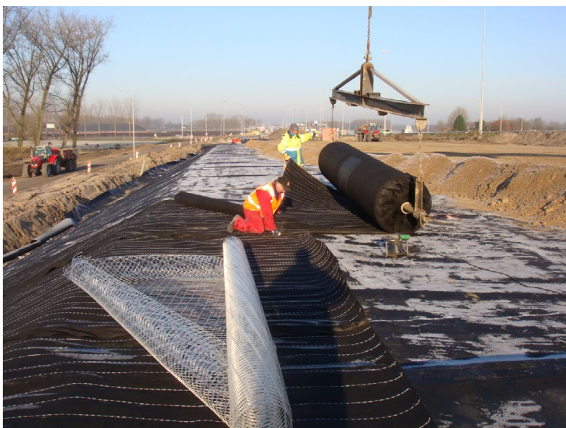
Foto: Bij 11: Aanbrengen drainagemat en geogrids.
